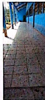
Foto 4: Finalización piso de interior y exterior
