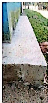
Foto 3: Finalización de piso de interior y exterior
