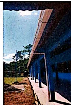
Foto 6: Finalizando canales y bajadas de agua pluvial.
