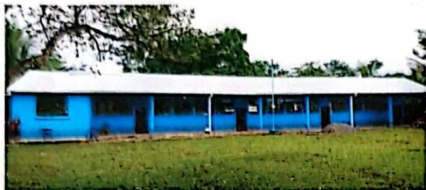
Foto 1: Finalización de cubierta de lamina
